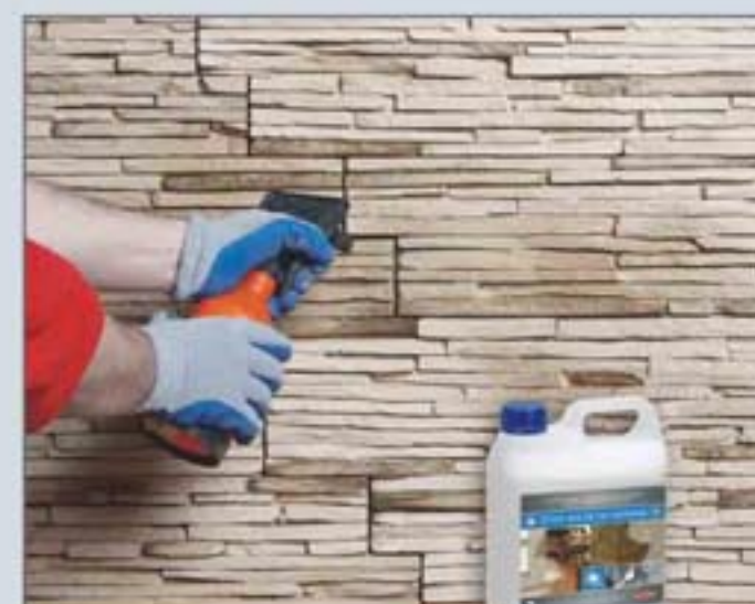
5. Impregnacja środkiem STEGU ŻYWY KOLOR DO KAMIENIA Impregnation with STEGU ŻYWY KOLOR DO KAMIENIA
