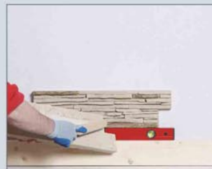
3. Oczyszczanie okładzin ściennych Cleansing of the facing
